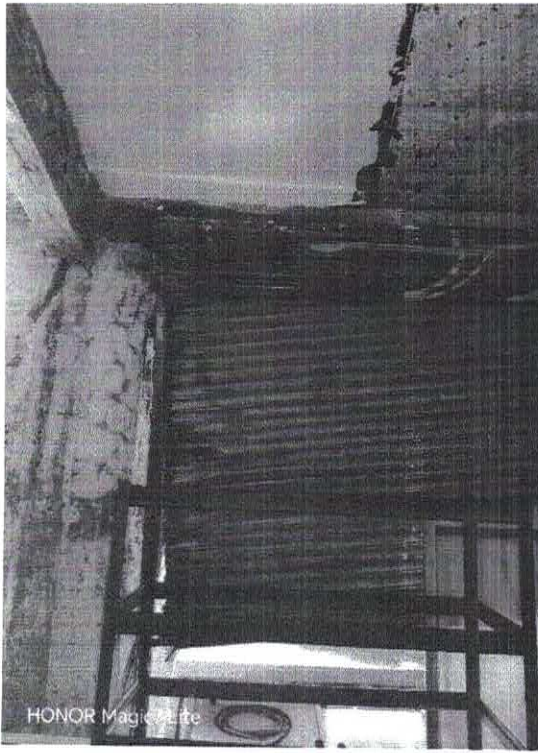
Figura 1. Daño en la cortina de la entrada del local.
